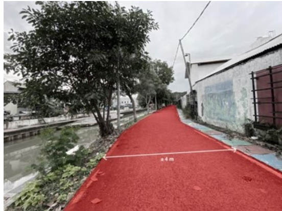
Gambar 4. Kondisi Eksisting Jalan
