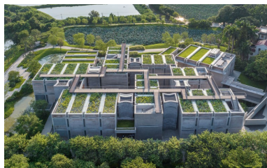
Gambar 4. Kolam teratai pada atap bangunan Pusat Seni dan Kebudayaan ChunYangThai
